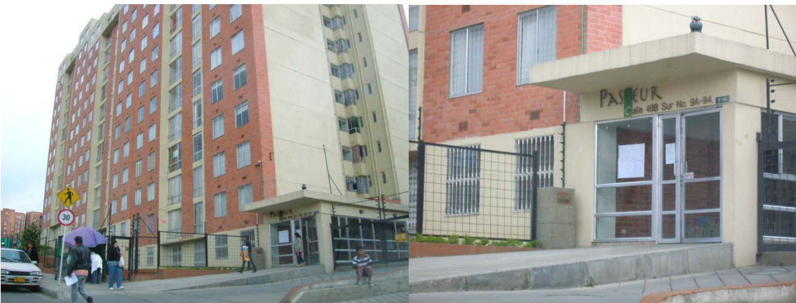
Conjunto Pasteur calle 49B sur No 9-94.
